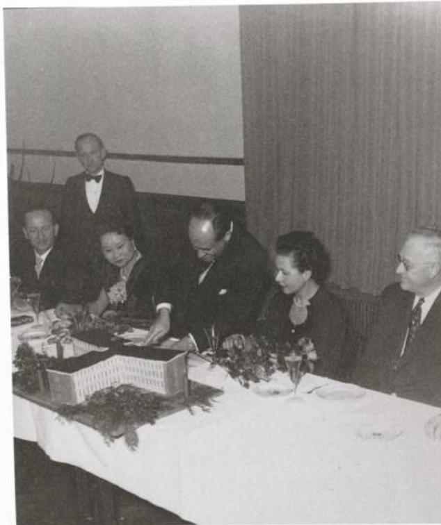
Richtfest im Rohbau mit internationalen Gästen, Arolsen, 20.8.1952
